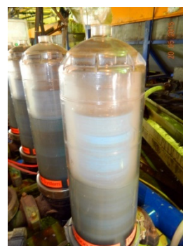
Рисунок 2. Самопромывные дисковые фильтры. (фото автора).
